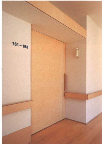
扉や手摺など、手に触れる箇所は、特注のパーチ積層合板で制作した
